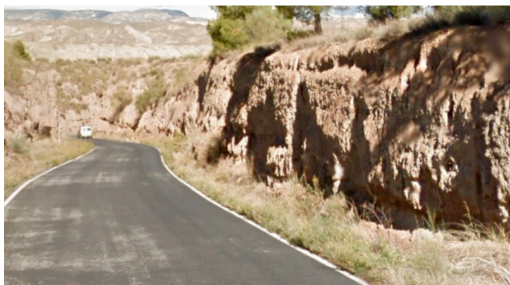
Foto: Carretera GR 7100.
