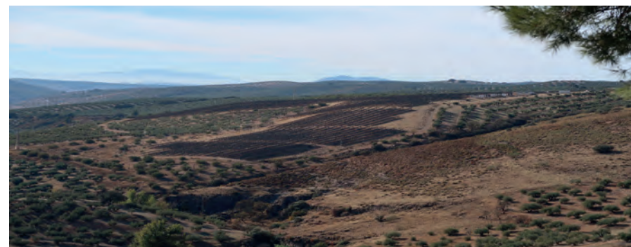
Fig. 19. Vista de planta fotovoltaica en el municipio de Iznalloz
