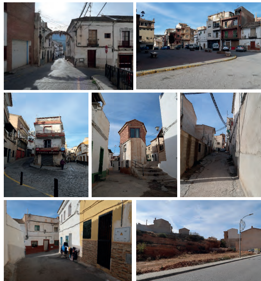
Fig. 30. Viviendas en mal estado y solares en el núcleo de Iznalloz
